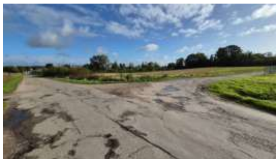
Pašvaldības autoceļš: Janeikas –Bajāri un pašvaldības autoceļš: Janeiku iela
